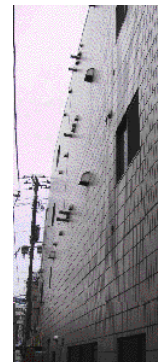
写真2 換気器具類の例
