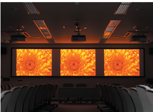
レーザー光源プロジェクターVPL-FHZ700を3台横並びに天吊り
