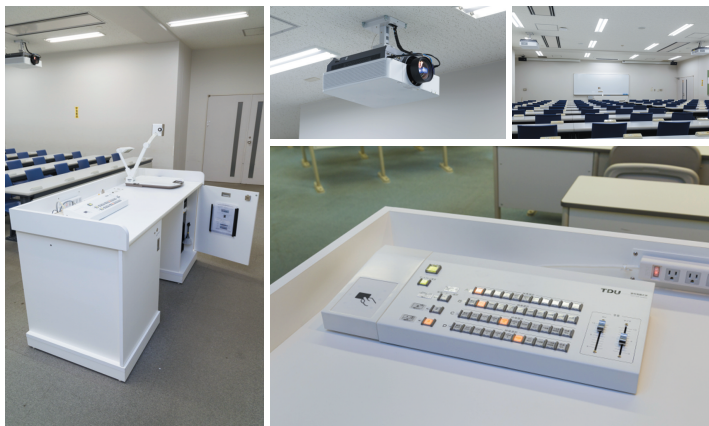
カードリーダーまですべて清潔感のある白に統一された操作卓
