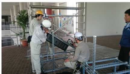
事前検証（傾斜角度測定の様子）
