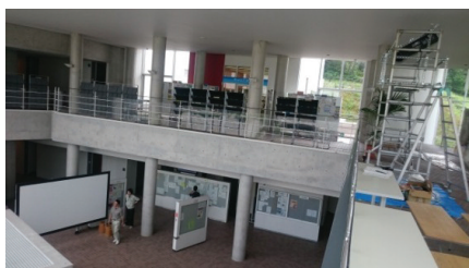
事前検証（仮設架台設置の様子）
