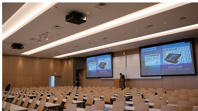
正面にブラックスクリーンを設置し、3チップDLP®レーザープロジェクターより投写する大講義室。音響は高音質なRAMSAラインアレイスピーカーと天井スピーカーを導入している
