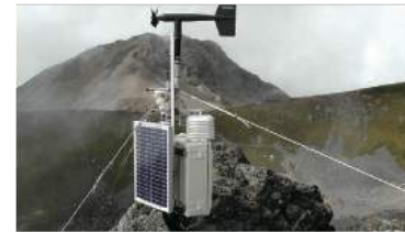
高標高地に観測設備を設置
