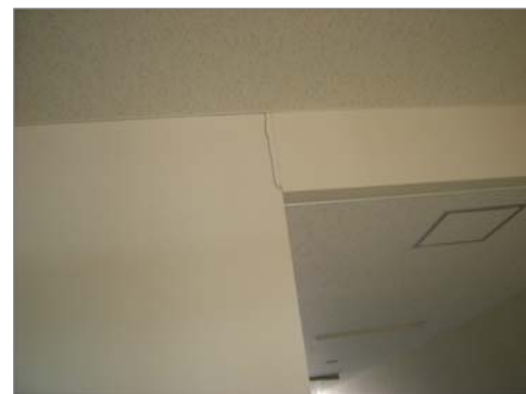
5号館(4階)・カフェテリア
