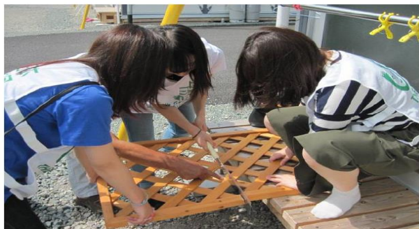
縁側の柵の設置(作業中)
